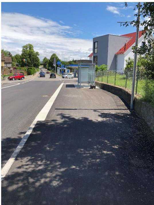
Bushaltestelle in Ergenzingen in der Gosbertstraße (bei Tankstelle)
